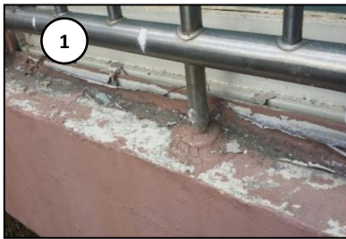
<수성페인트 노후로 인한 박리>
