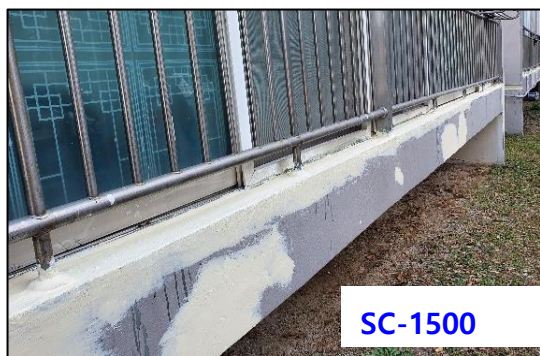
하도재 도포후 기능성퍼티 시공>
