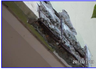
노출철근 방청 하도 + 방청재 ; SC-1000w
