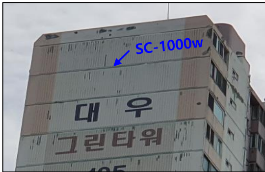
<외벽 균열보수 하도재 도포>
