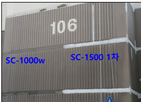
하도재 및 퍼티 1차색상 시공
