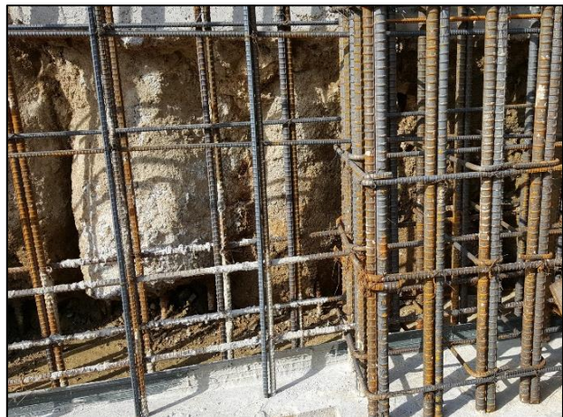
지하구조체 철근 배근
